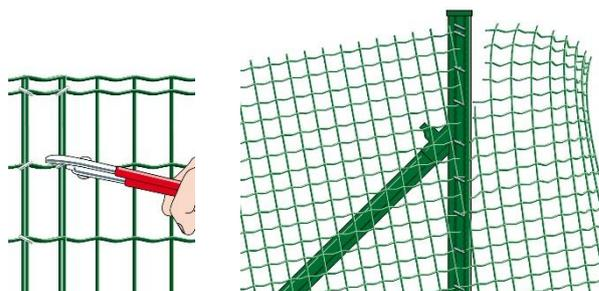
**7** Pro **dodatečné vypnutí sítě** použijte kreповací kleště. Jejich pomocí prohlubujte zvlnění vodorovných drátů, dokud nedosáhnete ideálního napnutí sítě po celé její délce. Stejným způsobem vyrovnejte nežádoucí bubliny a šikminy.
